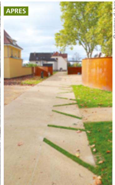
**En remplacement du chemin créé par incidence technique, pour la desserte de l'église, une allée de 3 m de large en béton désactivé a été réalisée. Sur une largeur de 1 m, celle-ci est entaillée de bandes engazonnées, posées sur une couche de fondation terre-pierre.**
