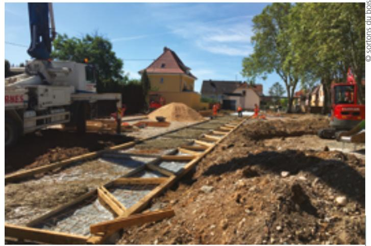
**La réalisation des allées en béton désactivé a demandé un vrai savoir-faire aux équipes d'Idverde : celles-ci ont dû coffrer chaque réglotte, ensuite engazonnée pour limiter au maximum l'imperméabilisation des surfaces.**
