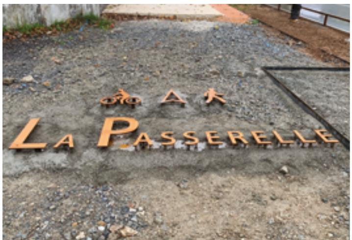
**Des lettrages en acier, à la teinte oxydée, ont été incrustés dans le béton des circulations piétonnes. Ils sont fixés dans une fondation béton, avant d'être pris dans la masse de la dalle béton. En cas de sablage, il s'agit de protéger l'acier de la projection de sable.**
