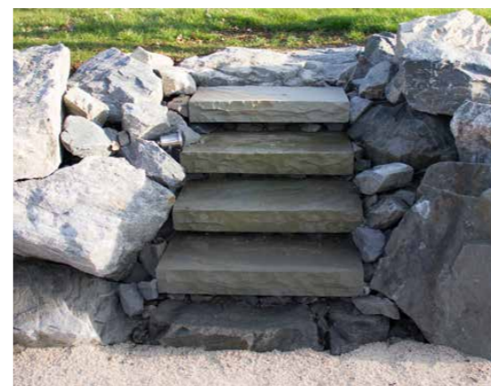
Le talus, d'un dénivelé de 1,5 m entre la cour et la pelouse, est franchissable au moyen d'un escalier de 5 marches en grès (1 m x 30 cm x 15 cm), éclairées par un spot 'Nautilus' de la marque Rexel.
