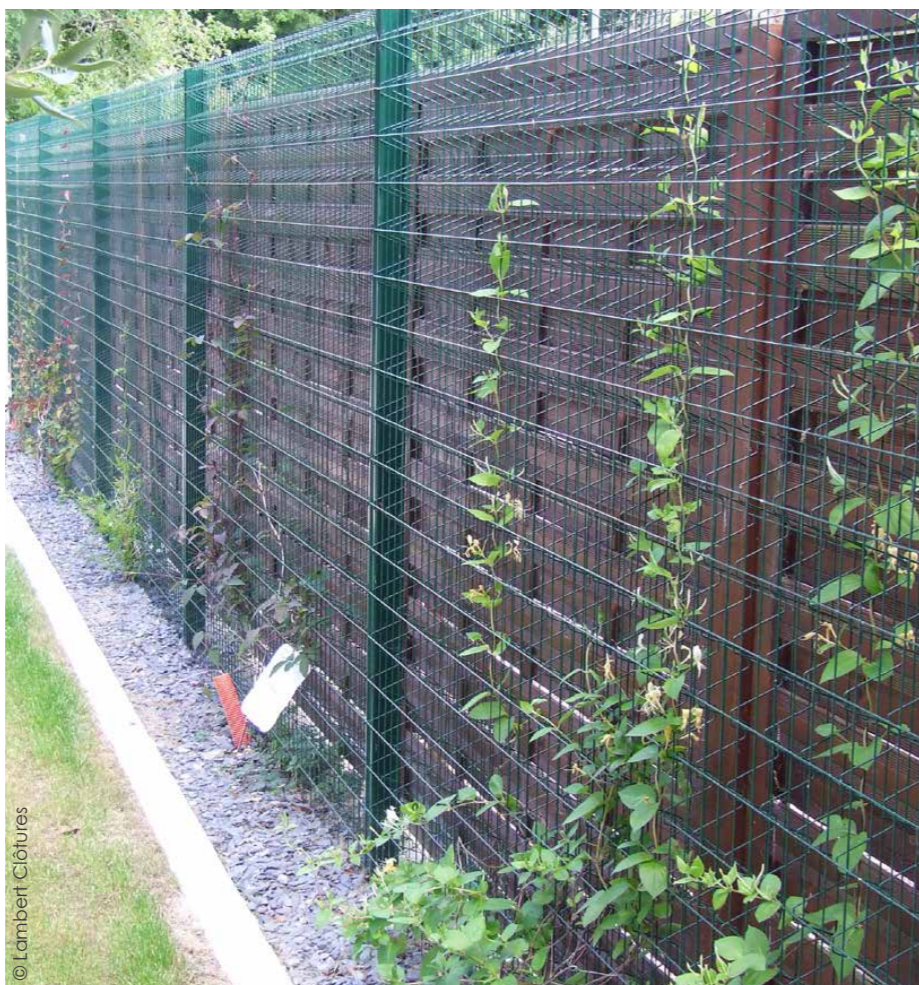
© Lambert Clôtures Le maillage 3D des treillis Bipalis, proposés par Lambert Clôtures, permet aux plantes grimpantes de s'y accrocher facilement. Cette solution camoufle certaines clôtures, jugées disgracieuses par les clients.
