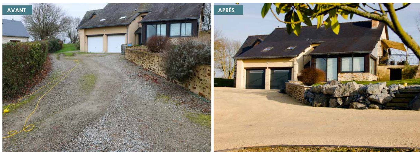
Pour mettre en valeur les abords de cette habitation, l'entreprise Maréchal Paysagiste a installé une cour et des allées en Baltazar®. Pour accompagner la pente, une centaine de blocs en grès armoricain ont été disposés à l'aide du godet d'une mini-pelle.
