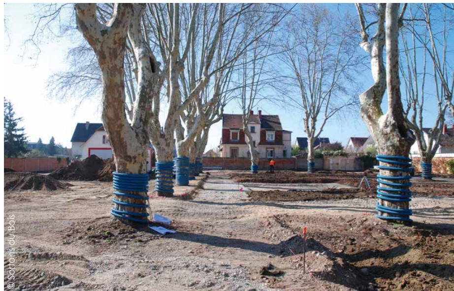
Un homme de pied était dédié à la surveillance du décaissement de l'ancien stabilisé (par mini pelle et godet de curage) afin de ne pas endommager le système racinaire des platanes. La terre végétale sous-jacente a été décompactée en surface (sur 10 cm), pour reconstituer un sol aéré.
