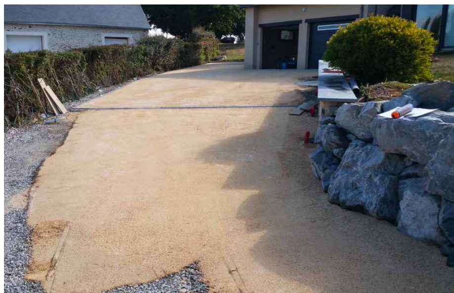
Les allées ont été réalisées en Balthazar®, une sorte de sable qui se minéralise sous l'effet de l'eau, du sel et du compactage. Dans un premier temps, un lit de grave 0/31,5 a été déposé, recouvert par du sable 0/6.
