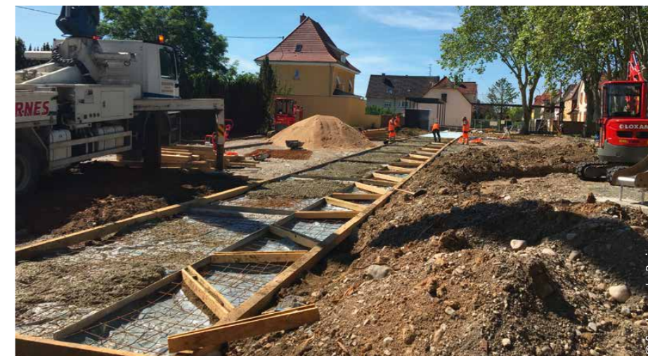
Sur 1 m de large, les allées principales reposent sur deux couches successives de terre végétale (15 cm), puis de mélange terre-pierre (20 cm), assurant une portance entre 50 et 80 NPA et un ensemencement des 'réglettes', pour une infiltration maximum de l'eau.
