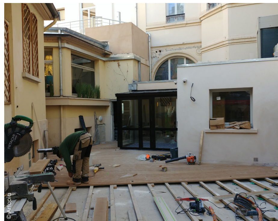
Les lames de terrasse (176 x 3 600 x 32 mm) sont fixées sur lambourdes (pin traité classe 4) à l'aide de vis inox discrètes. Ces lambourdes sont posées sur des plots réglables Jouplast tous les 80 cm.
