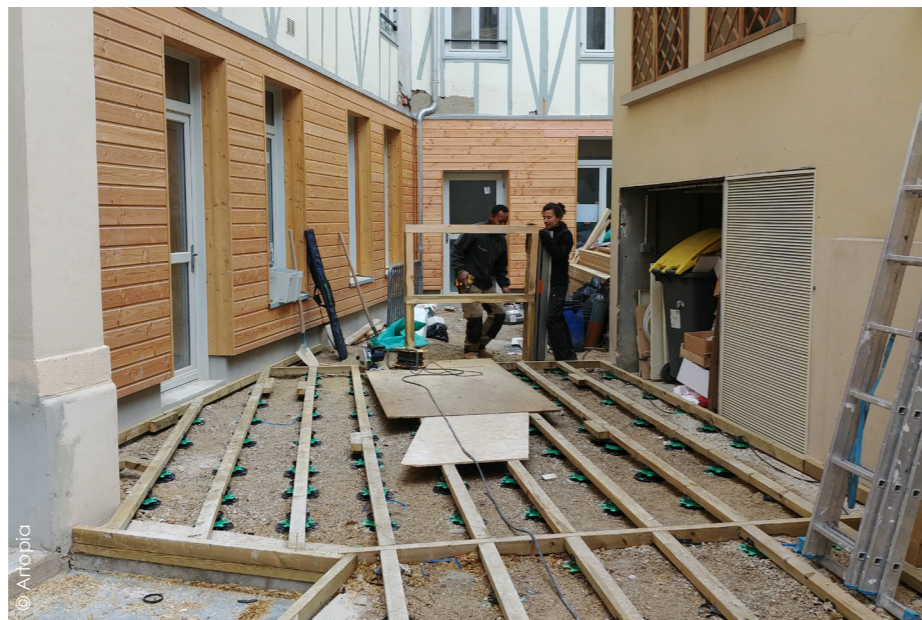
La principale contrainte pour les équipes d'Artopia était l'accessibilité au patio et l'exiguïté des lieux, avec une co-activité importante, nécessitant de ne pas gêner l'avancée du chantier par les autres prestataires. L'organisation était donc millimétrée.
