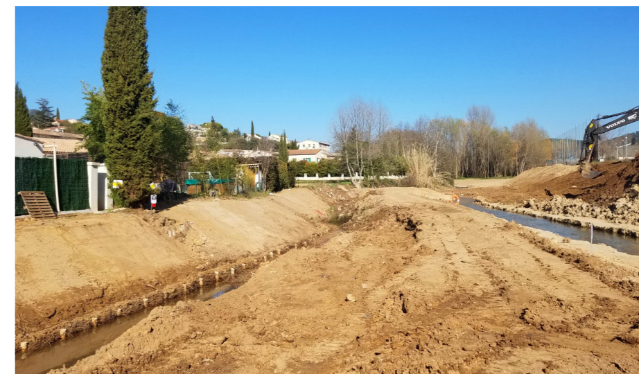
Les travaux ont débuté par les terrassements, avec plusieurs milliers de mètres cubes déplacés, afin d'offrir plus d'espace de divagation au fleuve, permettant alors de limiter les inondations.
