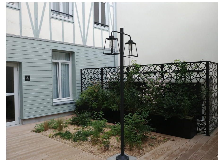
Des treillis noirs en acier, traités par cataphorèse et thermolaqués, boulonnés sur des poteaux en acier fixés au sol, servent d'écran visuel pour masquer les groupes de refroidissement mais aussi de support à des Clematis armandii.
