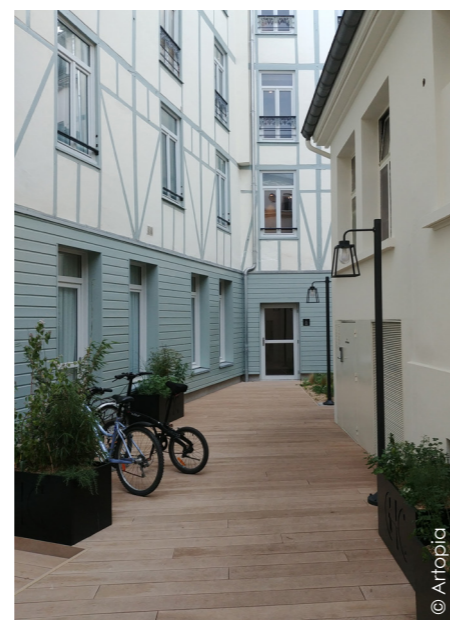
Le revêtement est en lames de résine minérale, finition "Grain fin chêne cuivré", de chez Anysyears. Ces lames ne se déforment pas avec le temps, contrairement aux lames de bois composite, tout en ayant l'aspect du bois, avec un grand choix de finitions.
