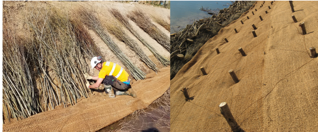
Pour réaliser des couches de branches à rejet, des fagots de branches sont d'abord disposés sur la berge décompactée, puis recouverts de terre végétale. Ensuite, un géotextile est déroulé, tendu et fixé par des pieux (1 U/m) reliés entre eux par un laçage en fil de fer.
