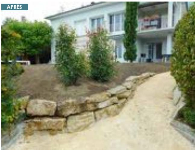
L'escalier droit qui permettait d'accéder à cette maison des années 1970 a été détruit pour être remplacé par une allée. Celle-ci monte sur 1,50 m depuis la rue, jusqu'à atteindre la porte d'entrée. Elle a été réalisée en stabilisé (1/3 de chaux, 2/3 de graviers concassés 0,5).
