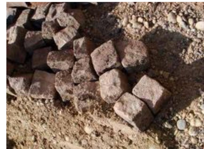
Recycler des pavés permet de limiter les impacts environnementaux d'un chantier et de réduire les coûts.
