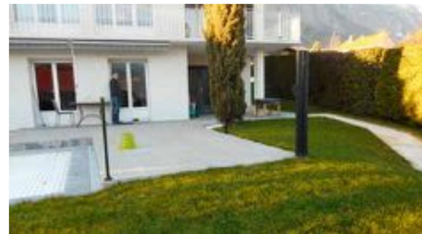
Une nouvelle terrasse, composée de dalles de béton gris anthracite, a été installée sur une fondation béton. Sa double pente d'1 % permet une bonne évacuation des eaux pluviales. Afin d'être à niveau par rapport aux seuils des portes de l'habitation, une marche a été ajoutée en bordure de la piscine.
