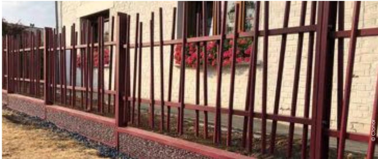
Voici une clôture mixte proposée par Clonor, intégrant des grilles Diago Aleacio® posées sur une clôture gabion.
